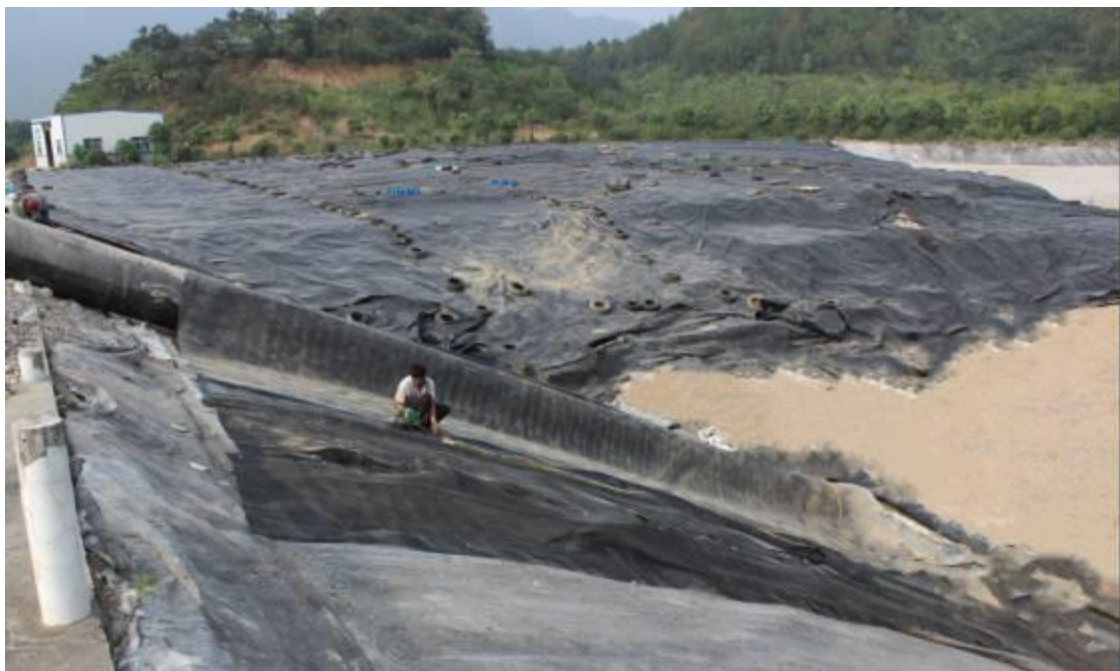
完工后现场照片
