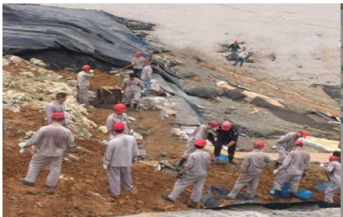
施工中现场照片
