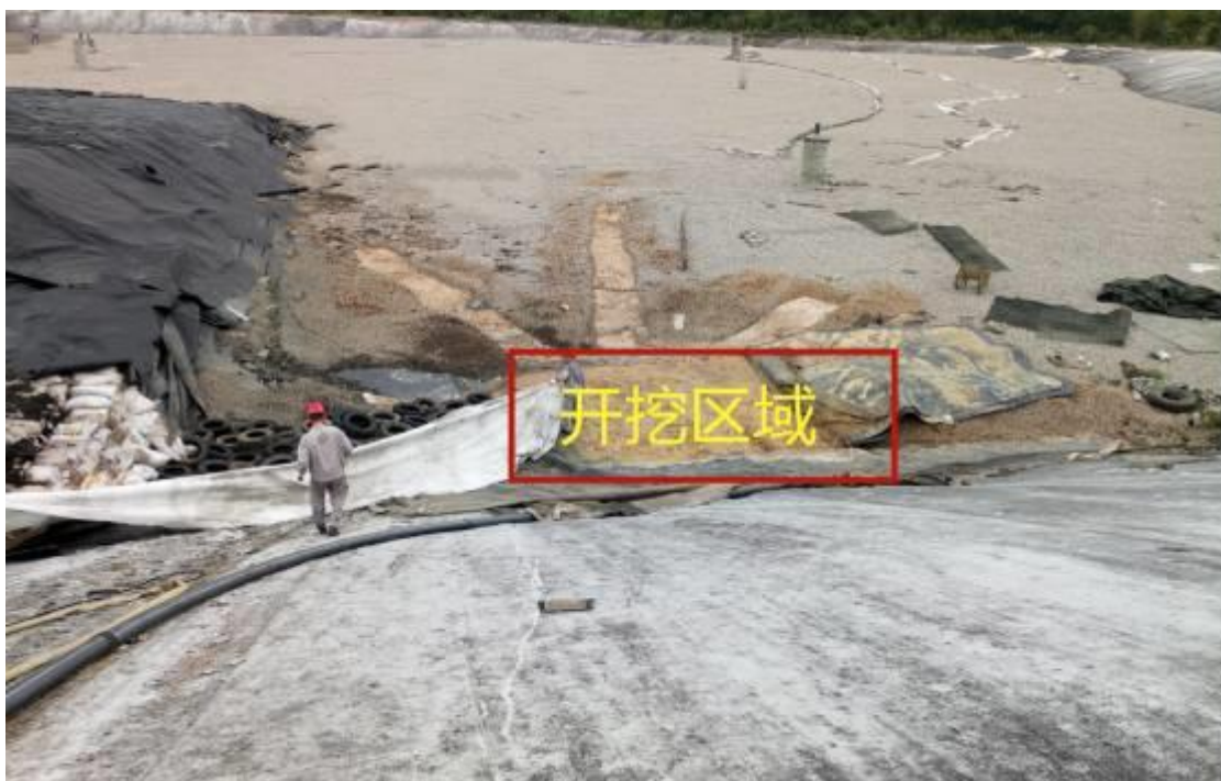
施工前现场照片
