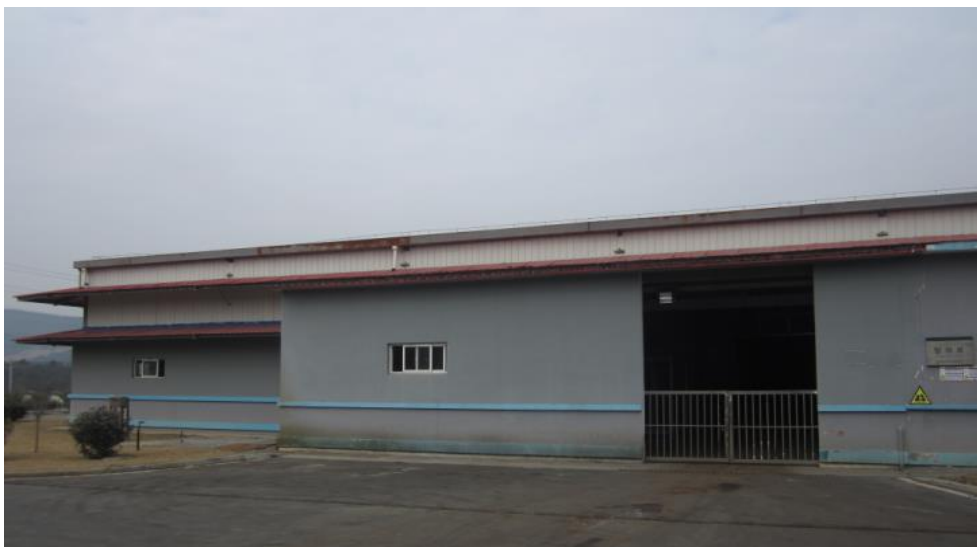
改造后暂存库现场照片
