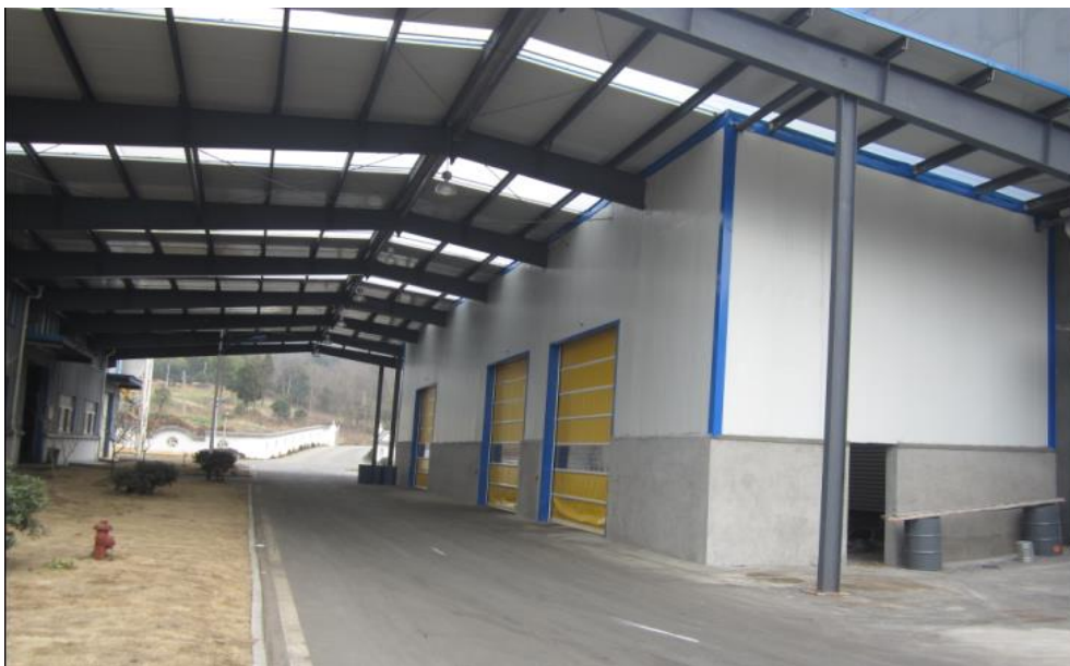
改造后焚烧车间料坑现场照片
