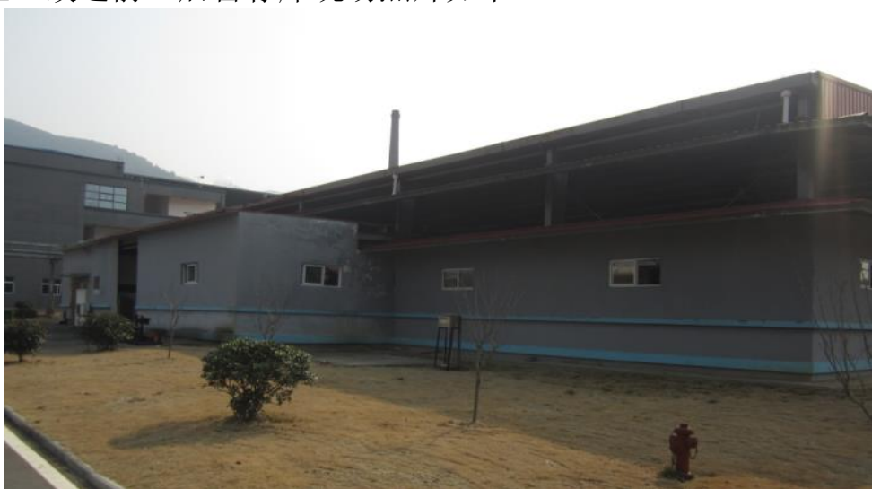
改造前暂存库现场照片
