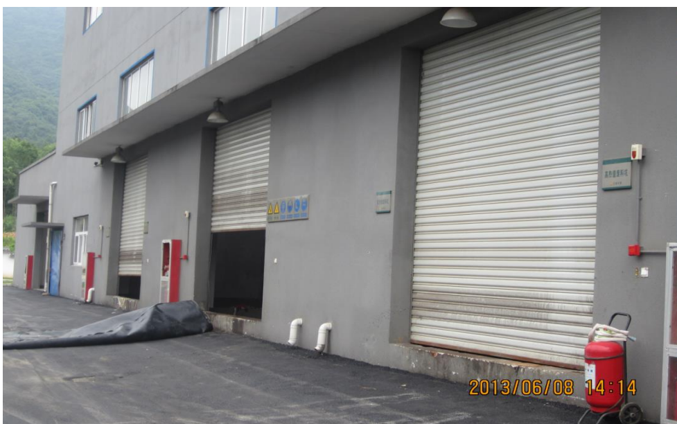
改造前焚烧车间料坑现场照片
